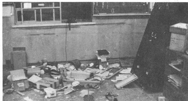
事務室 左上が受付窓口、机・椅子は持ち出されてなくなっており、電話交換台が破壊され、右の黒いロッカーもさかさまに倒されている。
