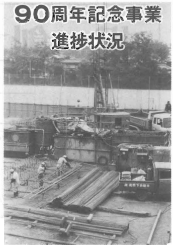
工事始まる第二体育館
